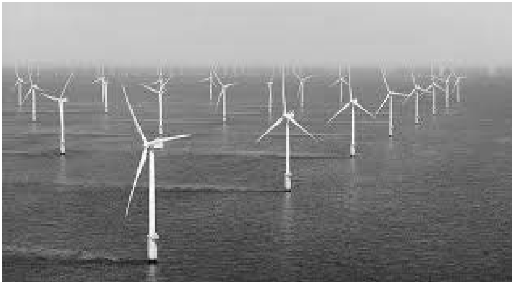
Рисунок 1. Розміщення вітроелектростанції Walney Extension (Великобританія) у відкритому морі.
