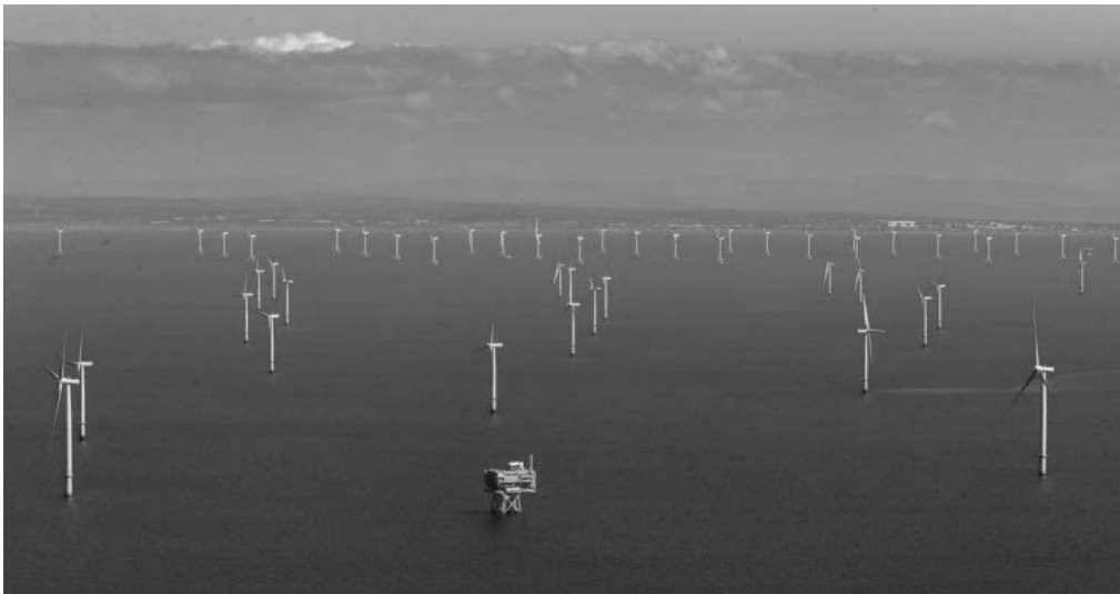
Рисунок 2. Розміщення шельфової вітроелектростанції Gemini (Нідерланди) у відкритому морі.
