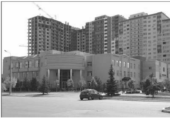
Рисунок 3. Реконструйована будівля колишнього банку з добудовою під Міжнародну приватну школу, вул. Закревського, 42, м. Київ.
