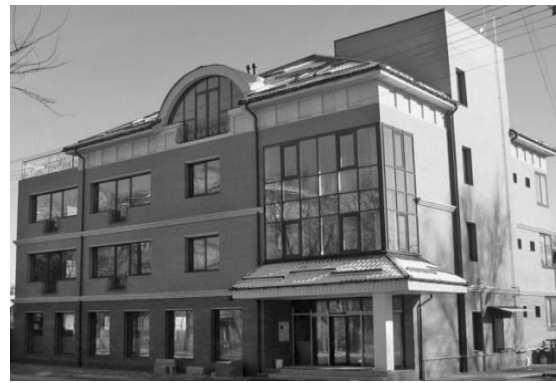
Рисунок 4. Реконструкція колишньої адміністративної будівлі під Приватну школу по вул. Андрія Головка, 13/1, м. Київ
